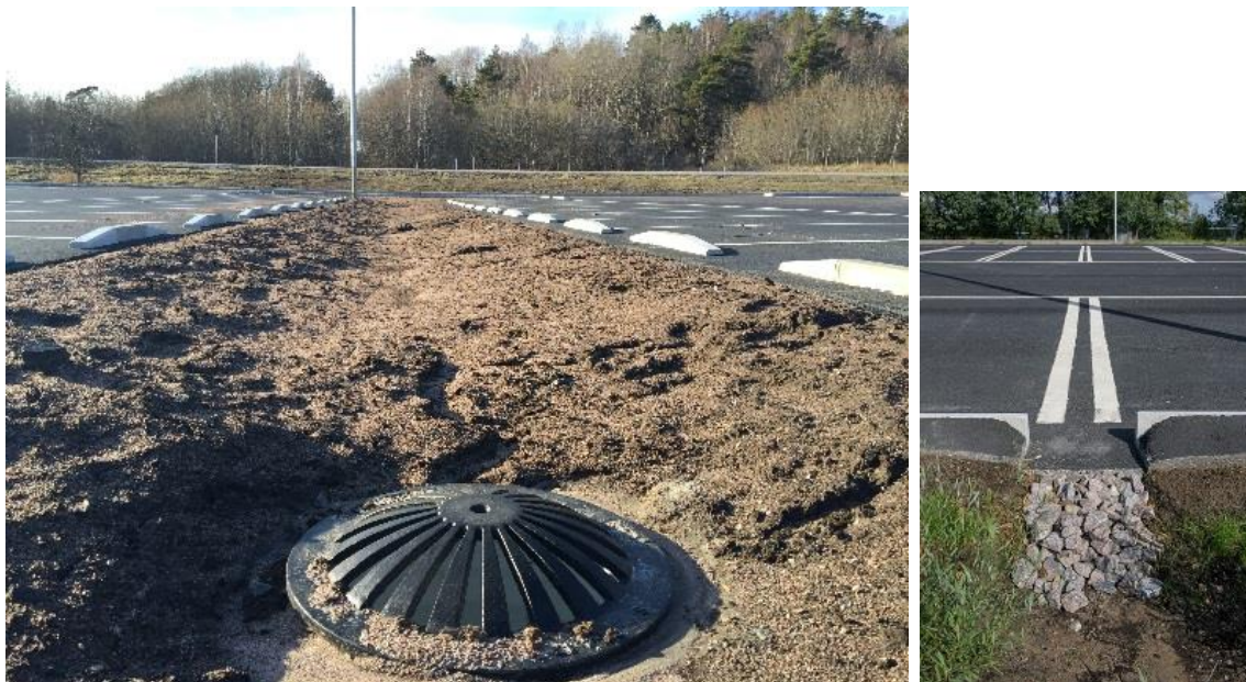
Figur 11. Exempel på nyanlagd översilningsyta från parkering. Foto: Per Norberg (vänster) och Peter Svensson (smhi.se, höger)
