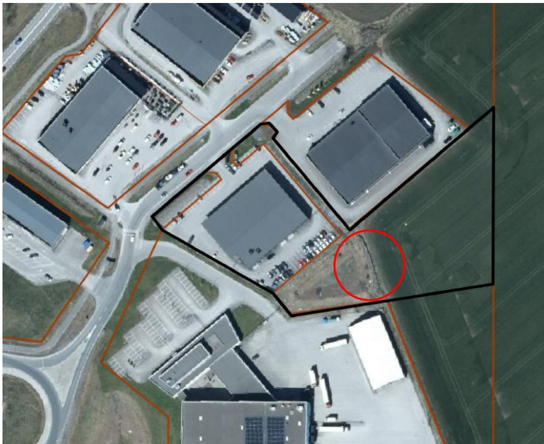
Bild 12 visar stenväggarna som omfattas av biotopskydd och vars delar kommer att påverkas vid ett genomförande.
