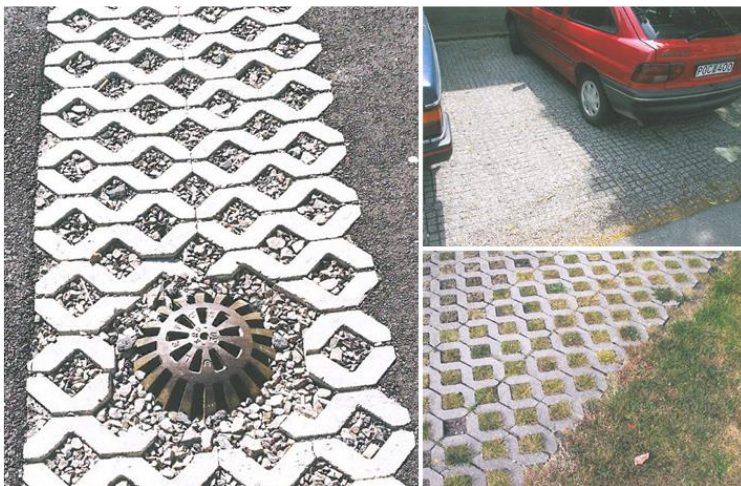
Bild 8 visar exempel på lösningar för lokal infiltration av dagvatten.
