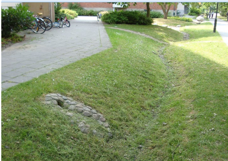
Exempelbild dike. Foto: Sweco
