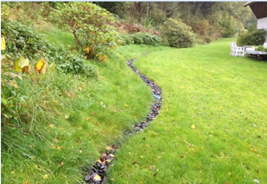
Exempelbild infiltrationsstråk. Foto: Sweco
