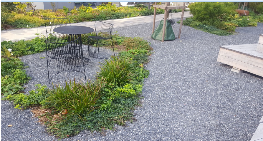
Exempelbild genomsläpplig beläggning. Foto: Sweco
